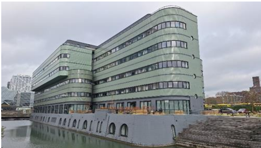
Het bestaande gebouw aan de Jan van Foreeststraat..
