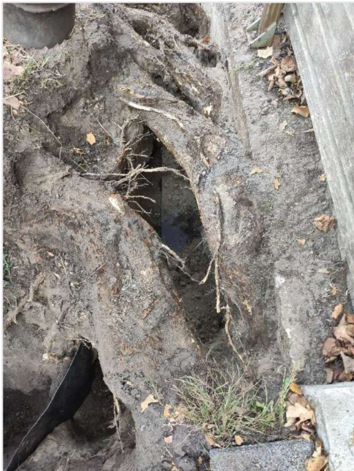
Afbeelding 15. Dikke beworteling richting de particuliere inritten, over het wortelscherm heen.
