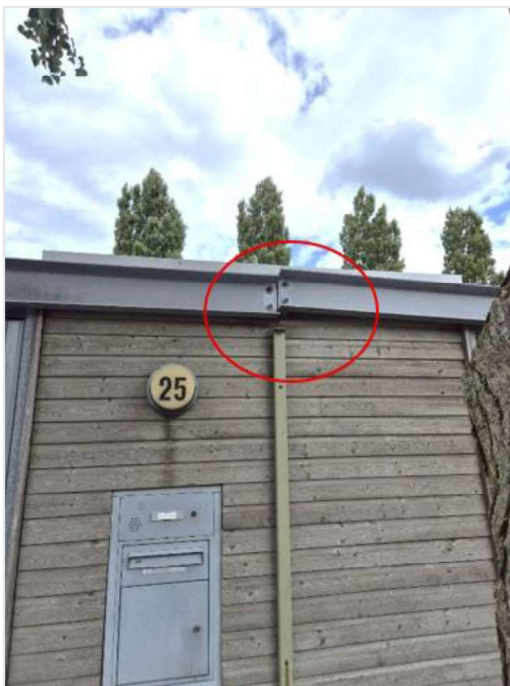
Afbeelding 6. Hoogteverschil tussen de balken van de hekwerken en het schuurtje. Huisnummer 25, Donsvlinder. Boomnummer 2009963.
