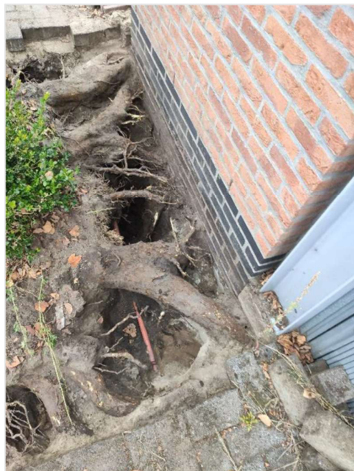
Afbeelding 18. Dikke beworteling richting particuliere inritten.
