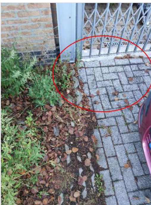
Afbeelding 10. Ernstige opdruk van verharding langs het hekwerk. Huisnummer 9, Donsvlinder. Boomnummer 1938629.
