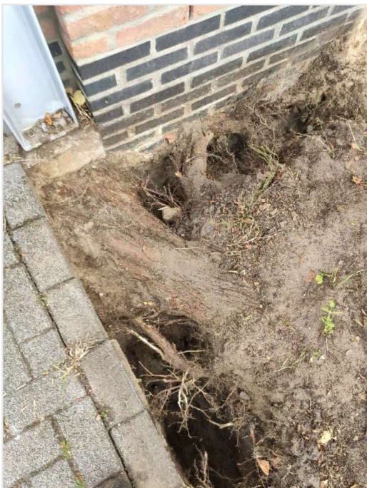
Afbeelding 17. Dikke beworteling richting particuliere inritten.
