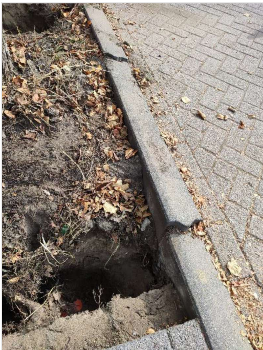
Afbeelding 8. Weggedrukte opsluitband. Huisnummer 9. Boomnummer 1938629.
