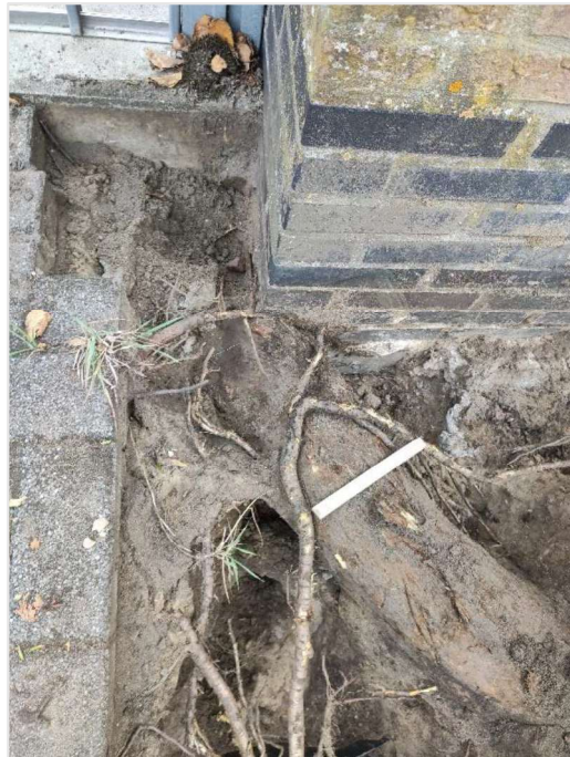
Afbeelding 16. Dikke beworteling richting particuliere inritten.
