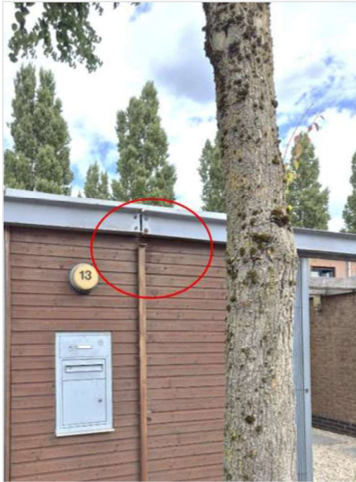
Afbeelding 12. Hoogteverschil tussen de balken van de hekwerken en het schuurtje. Huisnummer 13, Donsvlinder. Boomnummer 1895710.
