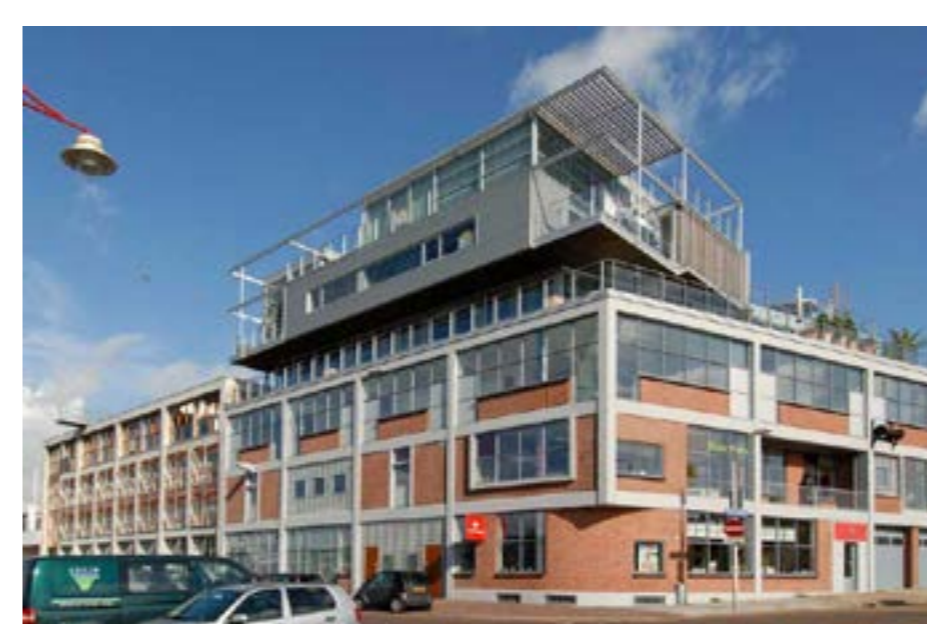
Bestaande bedrijfsgebouwen opgehoogd.
