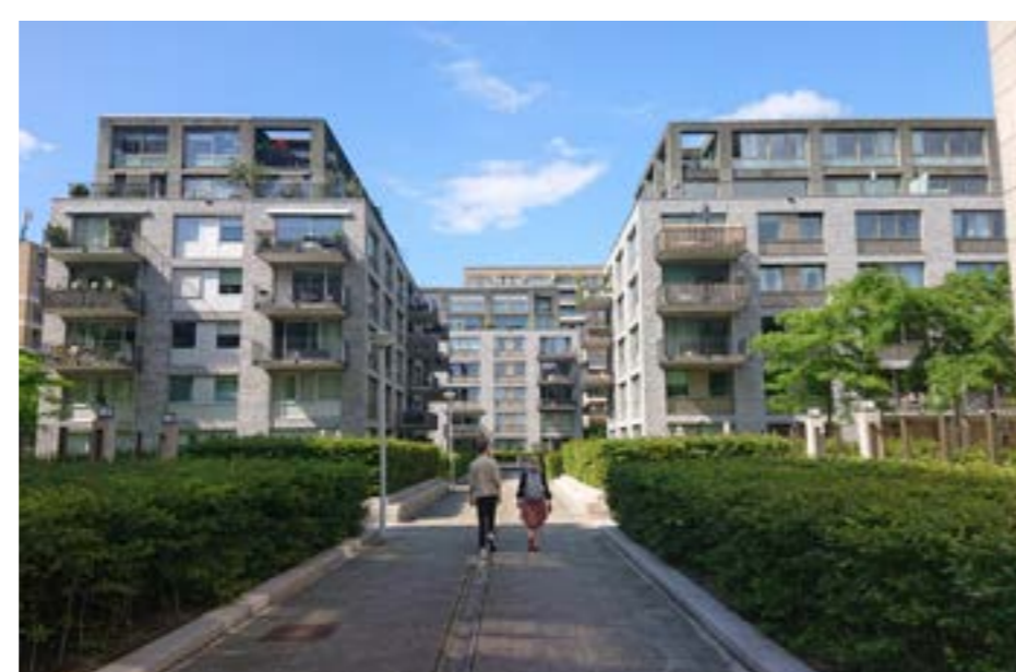
Bouwblokken met diverse groottes appartementen, Andreas Ensemble
