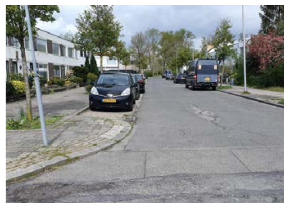
Asfalt toe aan vernieuwing
