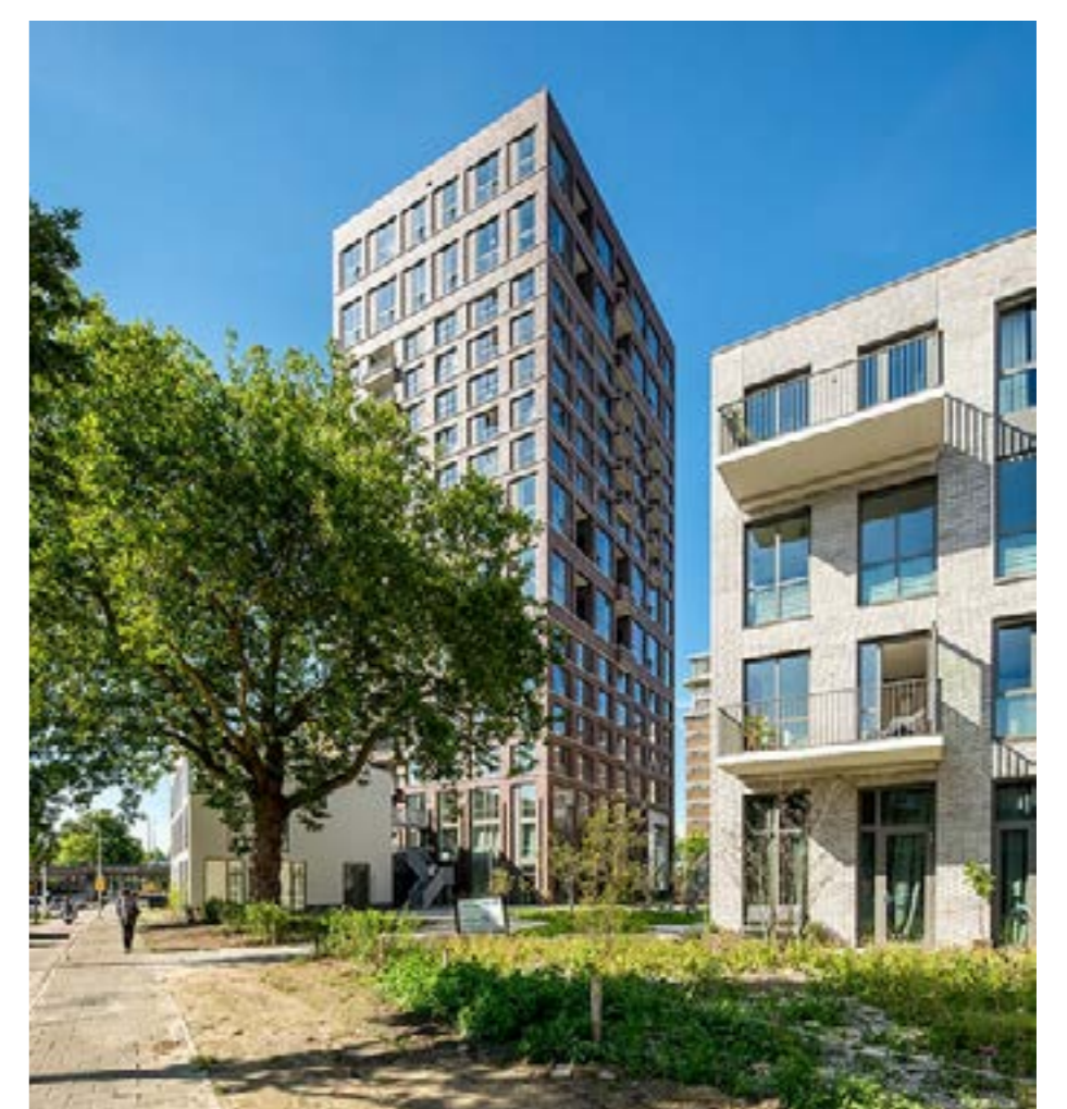
Nieuwe hoogbouw met studio's en appartementen, Eindhoven
