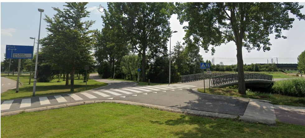
Figuur 6: Situatie aan de zuidzijde van de oversteek: door het weghalen van de lage begroeiing en het transparanter maken van de brugleuning wordt het zicht op de fietsers verbeterd
