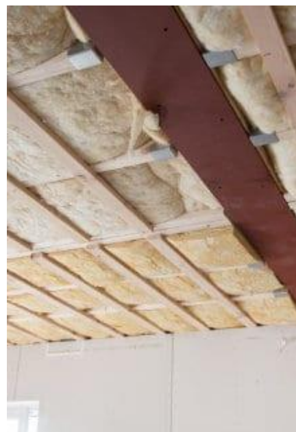
Figuur 11 Minerale wol aan binnenzijde aanbrengen
