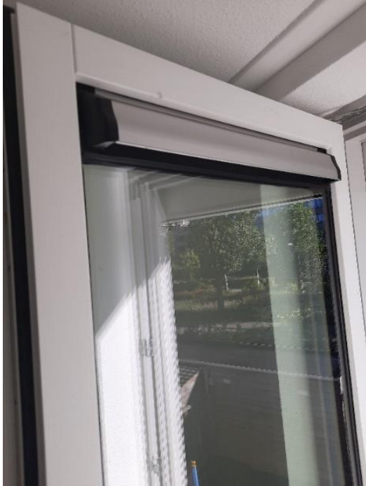
Figuur 5 Susrooster in draaiend deel
