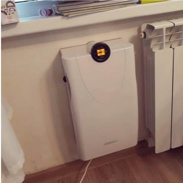
Figuur 1 Mechanische wandsuskast
