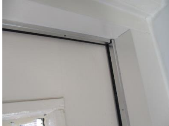
Figuur 9 Tochtstrips met onderbreking in de hoek
